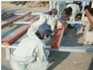
傾斜を確認しながら全て手作業で組み立て・設置
