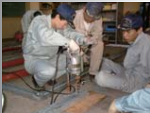
ステンレスボルト止めを行うため214カ所の穴をあける
