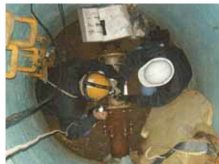
宮園丘陵地区配水流量計整備工事。宮園配水池にある宮園丘陵地区の流量計を更新しました。
