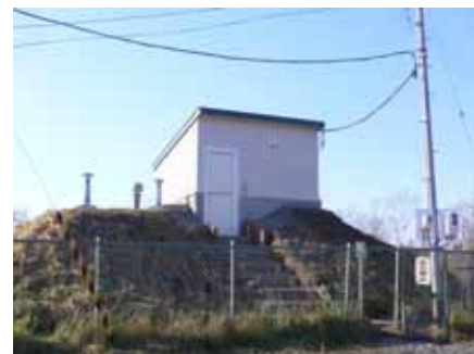
望洋台ポンプ室上屋改修工事。老朽化した門静望洋台地区ポンプ室の建物を改修しました。
