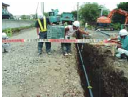
望洋台6号通り外1配水管布設替工事。道路工事に伴い配水管の布設替えを行いました。
