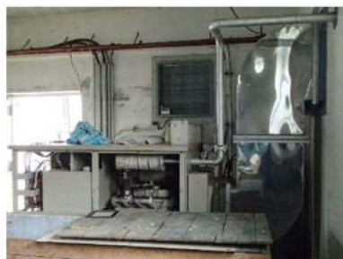
上水道取水ポンプ場非常用発電機嵩上げ前
