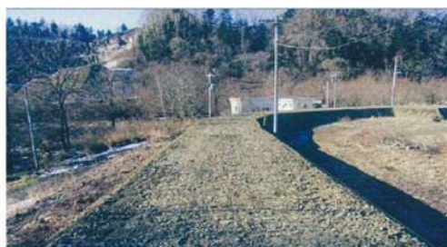
上水道取水ポンプ場連絡通路
