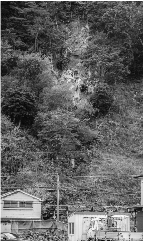
早く工事着工を！御供山崖の土砂崩れ（奔渡4丁目）
