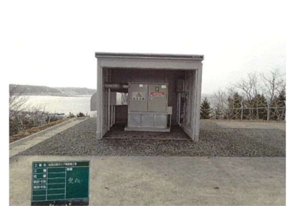
宮園丘陵ポンプ場整備工事
