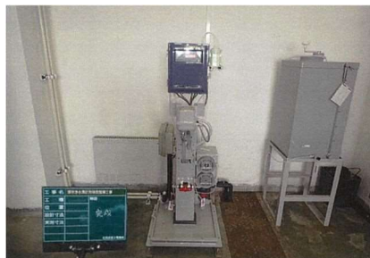
厚岸浄水場計測器整備工事
