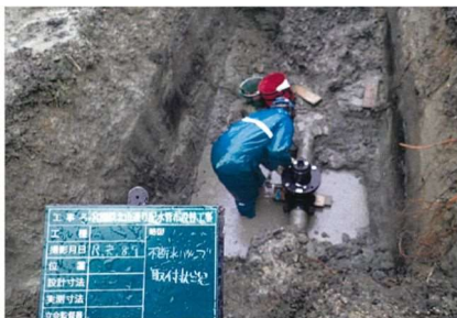
宮園鉄北山通り配水管布設替工事
