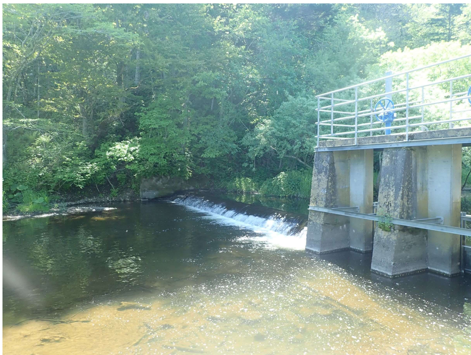
ホマカイ川取水場（鉄筋コンクリート造）
