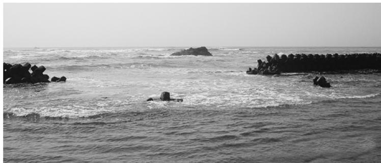
離岸堤開口部の崩落により航行に支障をきたしている末広西側地区。
