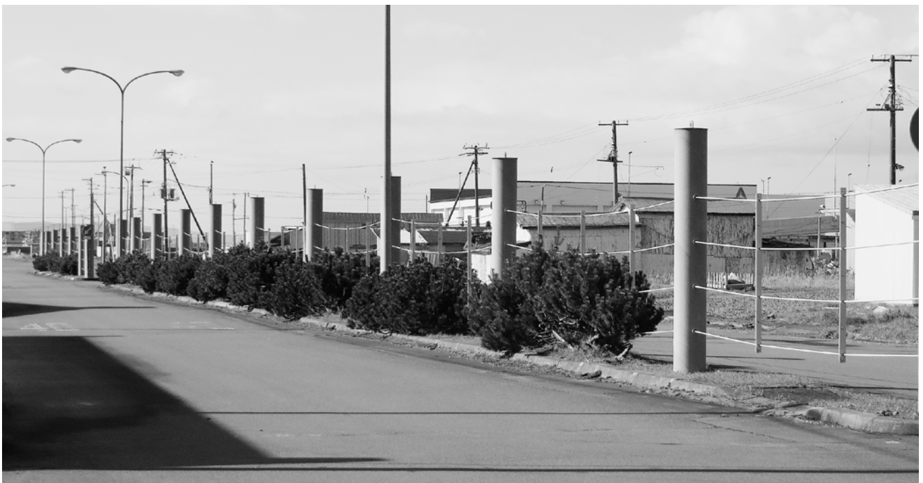
漁港道路の樹木や津波スクリーン
