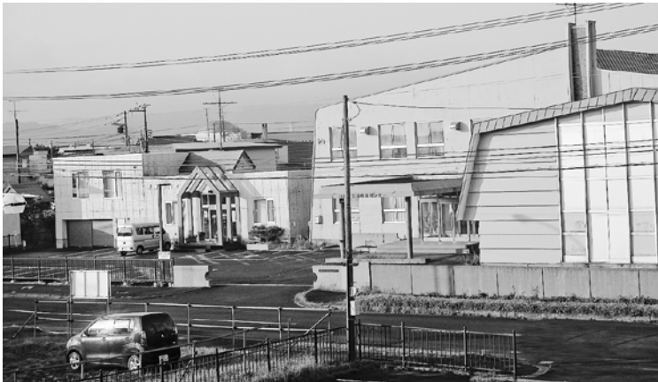
避難タワー・商工会事務所の併設を期待される生活改善センター
