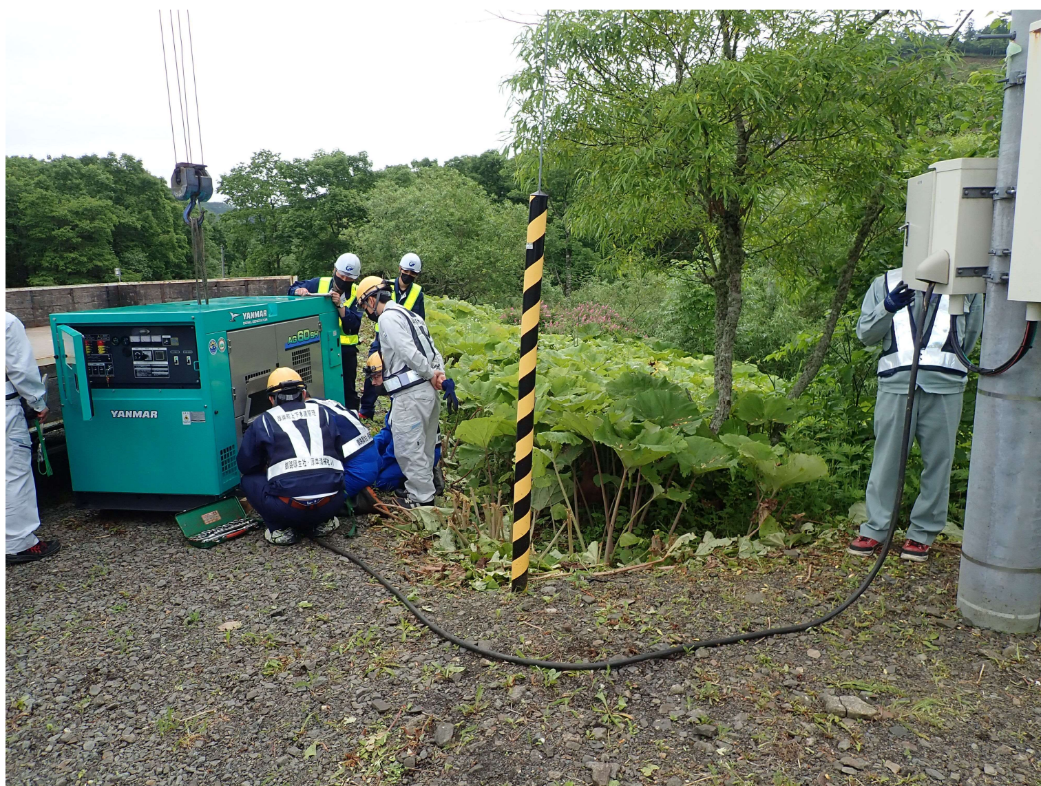
大雨により取水施設が不能となったことを想定した訓練 (上水道取水場にて可搬型発電機から電力を供給し、屋外操作盤で取水ポンプを運転する状況)
