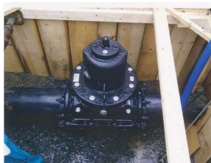
仕切弁整備工事
