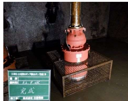
上水道取水ポンプ整備工事
