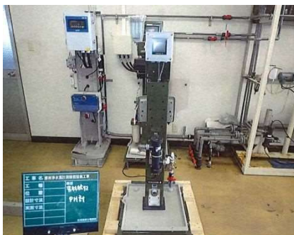
厚岸浄水場計測機器整備工事
