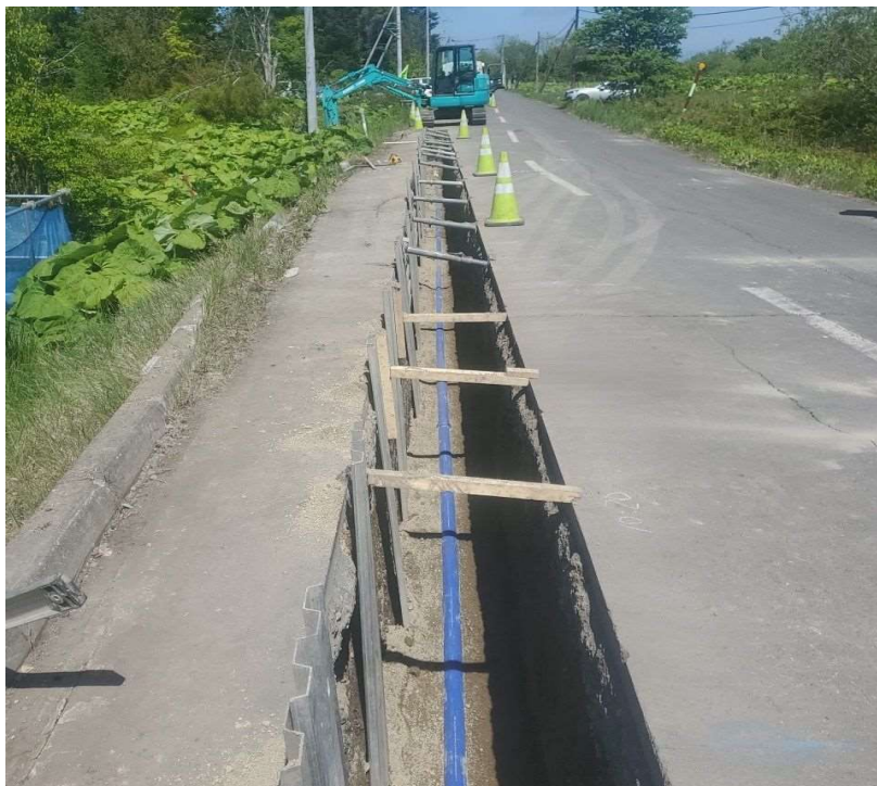
【配水管更新工事の布設状況】
