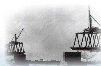
▲厚岸大橋橋桁工事
