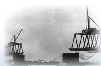
▲厚岸大橋橋桁工事
