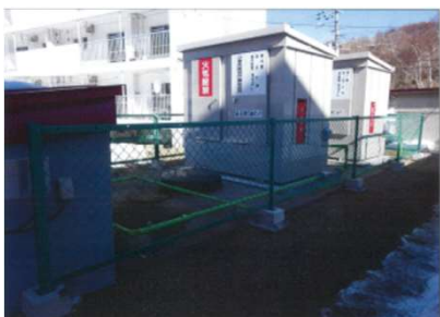
↑ 地下灯油タンク 給油管 消火器 フェンス
