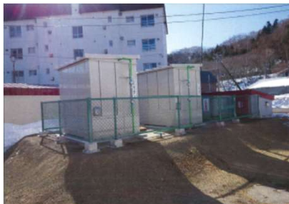
↑ 施工後(地下灯油タンク 給油管 フェンス)
