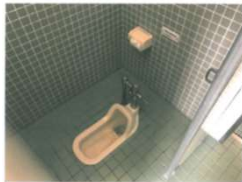
プール 男子トイレ 施工前
