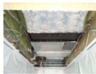
3階病棟下(天井内) 着工前
