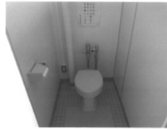
体育館 男子トイレ 施工前
