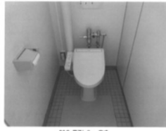
体育館 男子トイレ 完成
