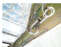
3階病棟下(天井内) 着工前
