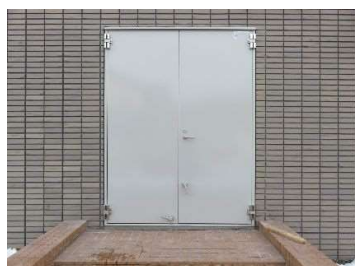
↑機械室及び電気室防水扉取替
