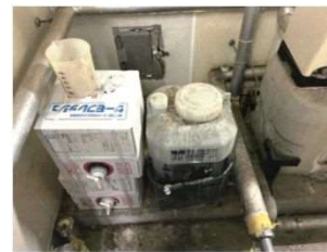
薬液注入装置 着 工 前
