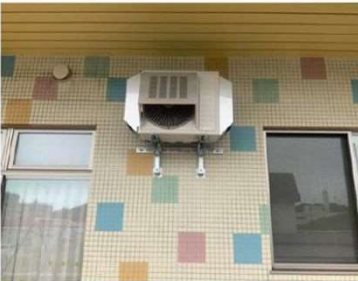
しんりゅう保育所 保育室1 窓 室外機 完 成
