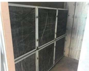
空調機NO1 フィルター室 着 工 前
