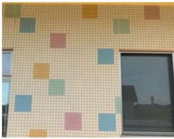
しんりゅう保育所 保育室1 窓 室外機 着 工 前
