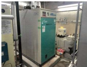
蒸気ボイラー 着 工 前
