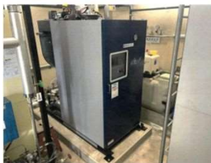
蒸気ボイラー 完 成
