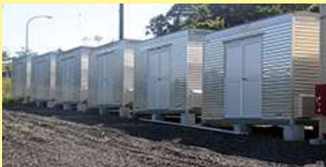
▼湖南地区防災広場の備蓄倉庫
