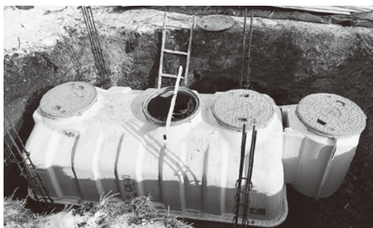
合併処理浄化槽
