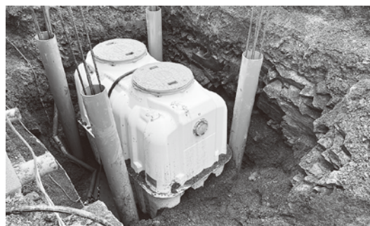
合併処理浄化槽
