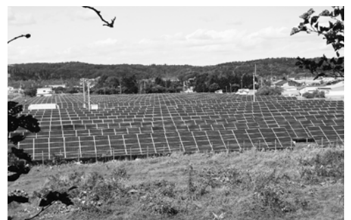
太陽光発電施設
