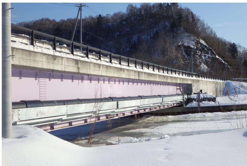
上記写真のホマカイ橋に付けられている水道管は、人口の9割が利用している水を運ぶための重要な水道管です。この水道管は平成26年にホマカイ橋の架け替え工事に伴い更新しました。
