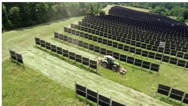
垂直設置型太陽光パネル
