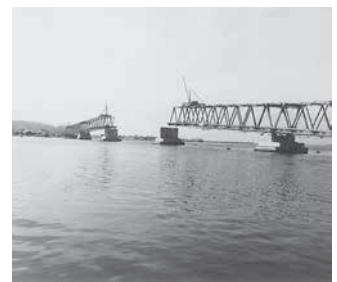
建設中の厚岸大橋(昭和)
