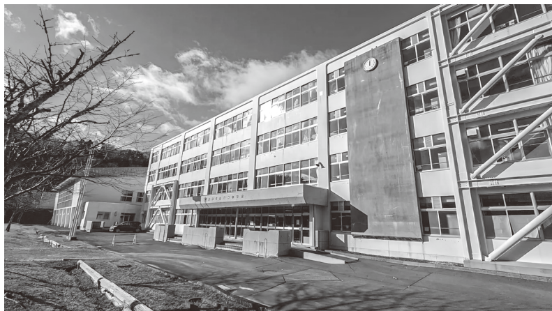
赤水が発生している厚岸中学校
