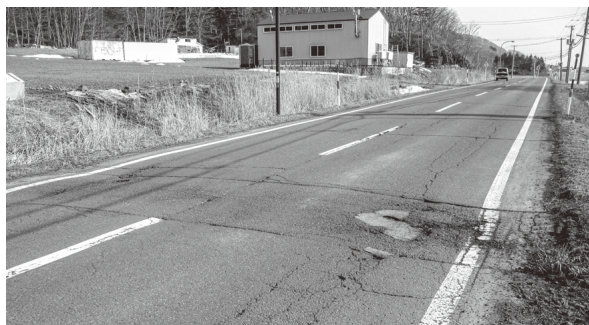
床潭住民要望の市街入口道路
