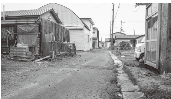
整備が必要な港町横1の通り
