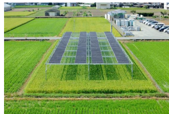
橋爪建材株式会社 30.57kW (927㎡) https://www.hashizume-kenzai.co.jp/2022/02/21/営農型ソーラーシェアリング/
