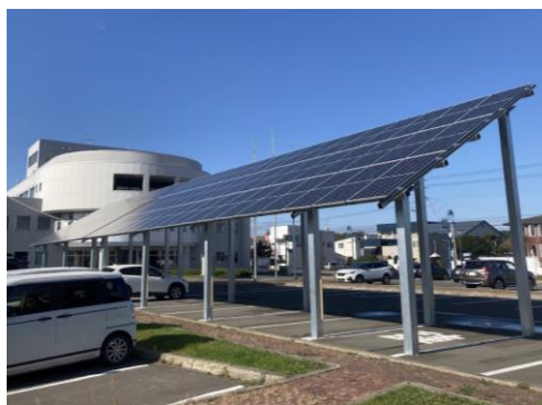
厚岸町役場駐車場
