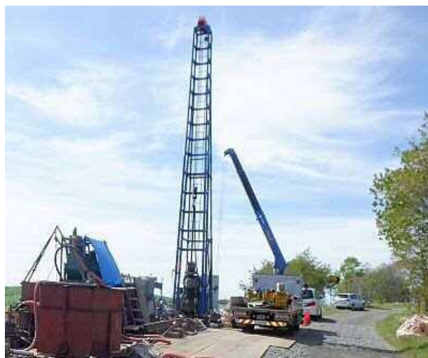
【令和6年度大別地区井戸掘削状況】
