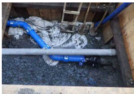
住の江町通り配水管布設替工事
