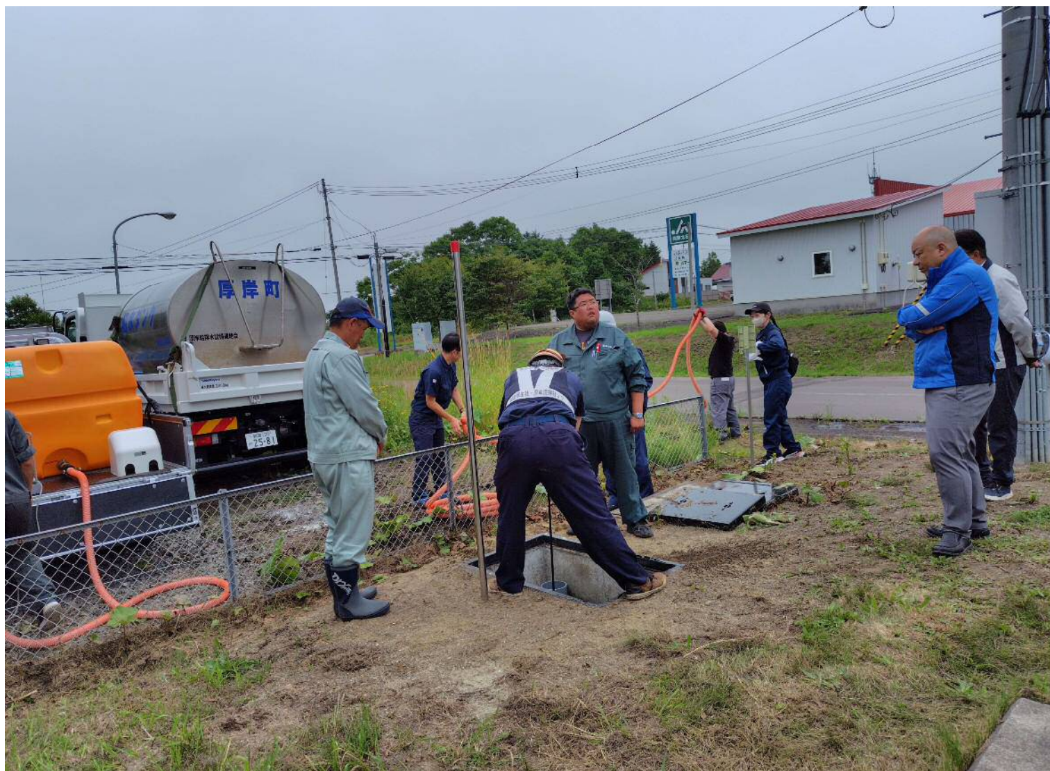
災害対策訓練実施時の太田活性化施設への応急給水訓練状況
