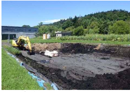
厚岸浄水場天日乾燥床整備工事
