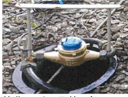
検満メーター取替工事
