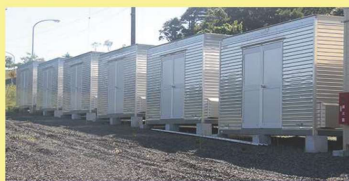
▼湖南地区防災広場の備蓄倉庫
