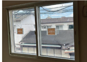
主居室の南側に内窓設置
