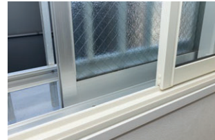
全住戸の内窓設置を実施
