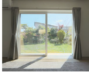
外窓交換(はつり工法)を実施
