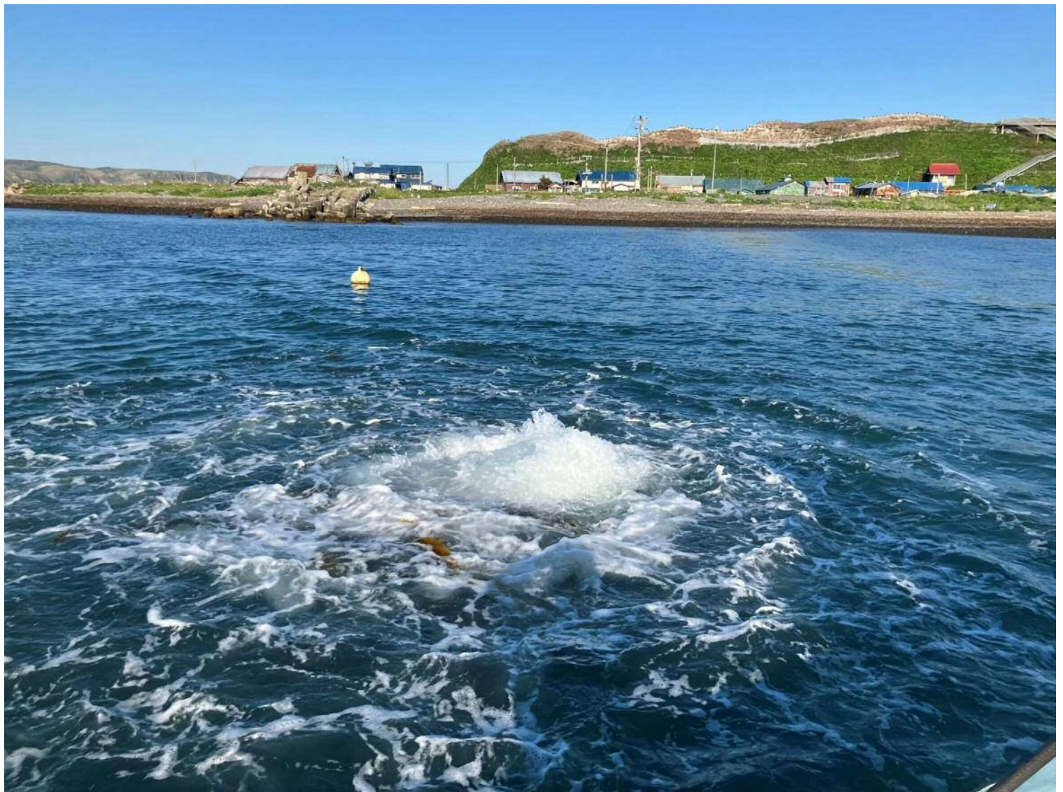
小島床潭間の海底送水管漏水状況
