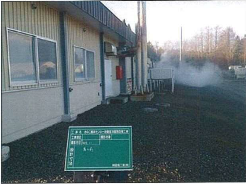
着工前 熱源埋設配管
