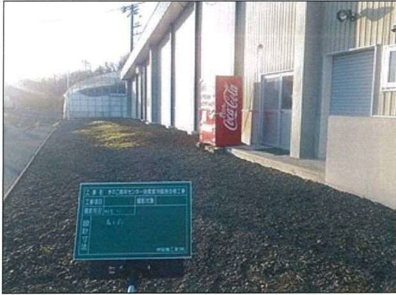
着工前 機械室
