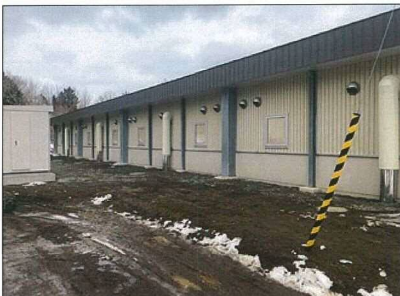
完了 換気ダクト
