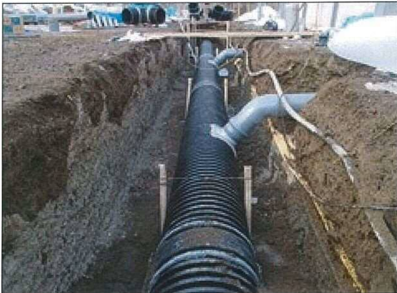
施工状況 換気ダクト
