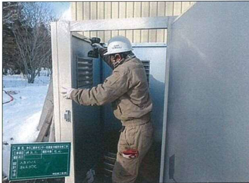
施工状況 給気ボックス
