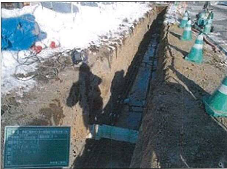
施工状況 熱源埋設配管
