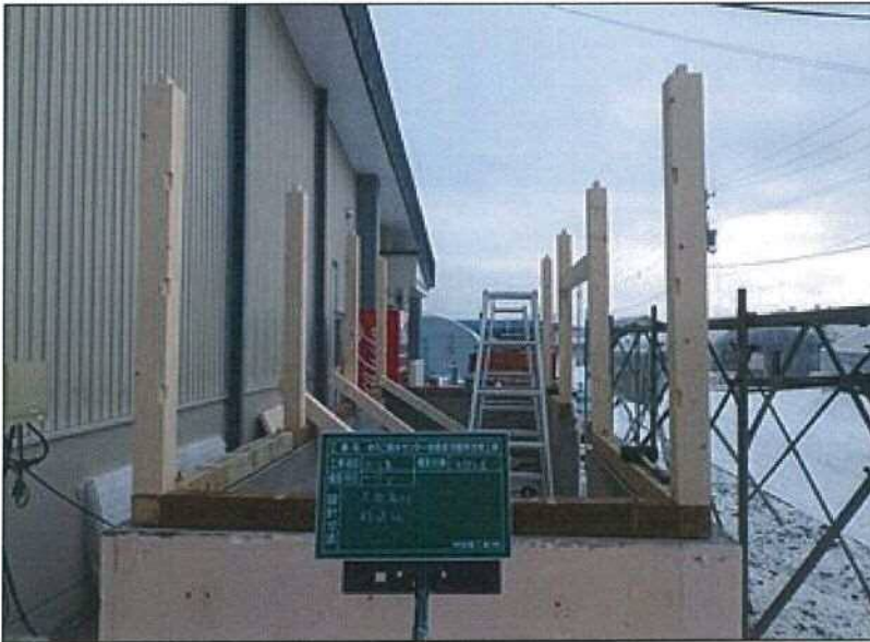
施工状況 機械室
