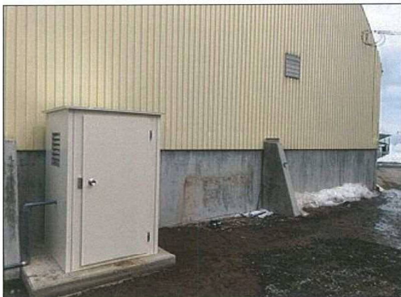
完了 給気ボックス
