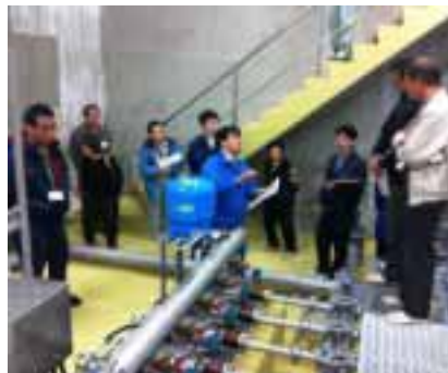
〔左〕施設見学会で説明を受ける地域の皆さん(場内のポンプ室)
