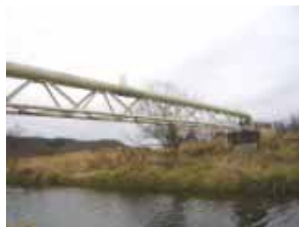
尾幌水管橋配水管
