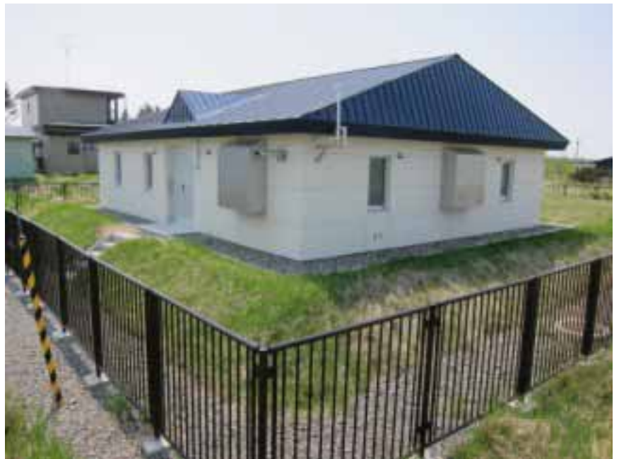
〔上〕完成した大別浄水場
