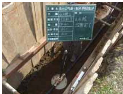
住の江町通り配水管布設替工事。道路工事に伴い配水管の布設替を行いました。同時に各戸へ行く給水管の接続替えも行い、漏水などが無いことを確認しています。
