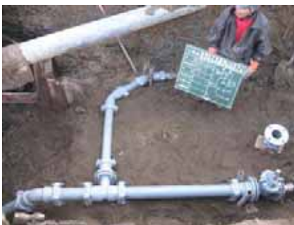
住の江町通り配水管布設替工事。道路工事に伴い配水管の布設替を行いました。同時に各戸へ行く給水管の接続替えも行い、漏水などが無いことを確認しています。
