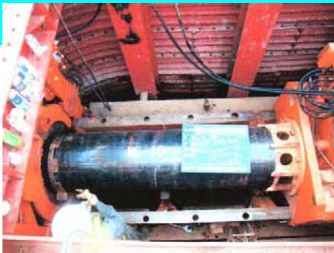
白浜町海岸通り送水管布設替工事。門静にある浄水場から宮園配水池までを結ぶ送水管の一部を布設替しました。鉄道敷地を横断するため、トンネルを掘るように地中を進んでいきます。
