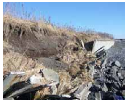
〔上〕 波によって大きくえぐり取られた町道白浜町海岸通りの崩落現場
