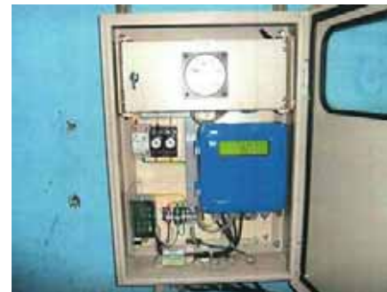
宮園配水池流量計整備工事。宮園配水池の流量計を更新しました。町内最大の配水池から湖北、湖南地区に給水される流量を計る重要な装置です。
