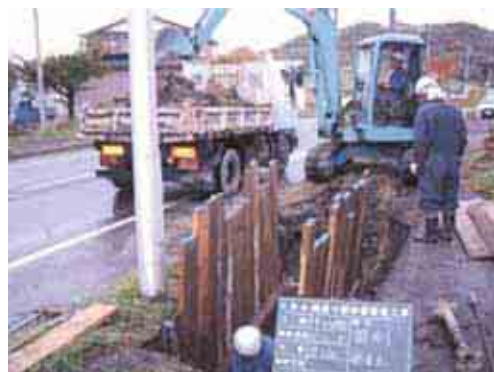
桜通り配水管新設工事。奔渡5丁目の桜通りに水道管を新設し、この地区の水圧不足を解消した。
