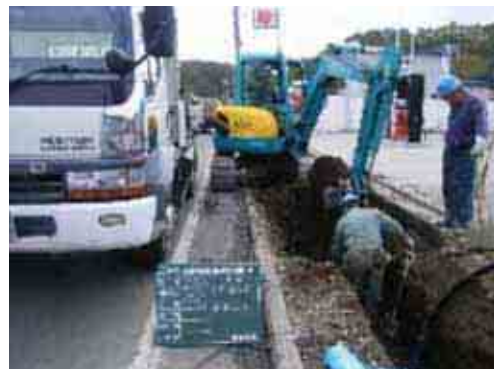
道道別海厚岸線配水管布設替工事。道道別海厚岸線に布設の老朽化した水道管を取り替えた。
