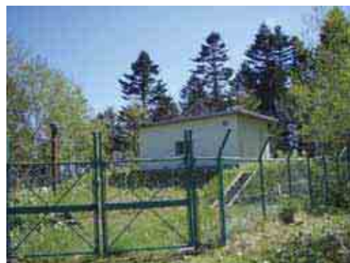
床潭市街地に水を供給している床潭配水池。老朽化したテレメーター（流量や水位を浄水場に伝送する装置）と残留塩素計を取り替えた。
